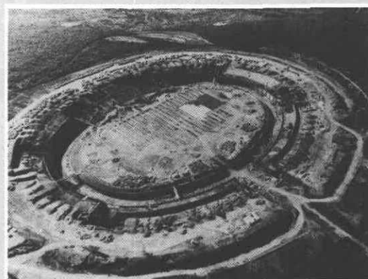
Construção do estádio do Mineirão, inaugurado em 1965. Acervo do Arquivo Público da Cidade de Belo Horizonte.
