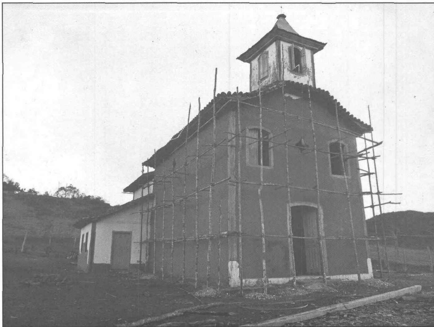
Itacolomi - Capela de São José em restauração.
