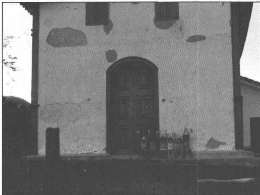
Distrito de Dep. Augusto Clementino. Detalhe da fachada da Capela de São Sebastião. (Foto: acervo IEPHA/MG)
