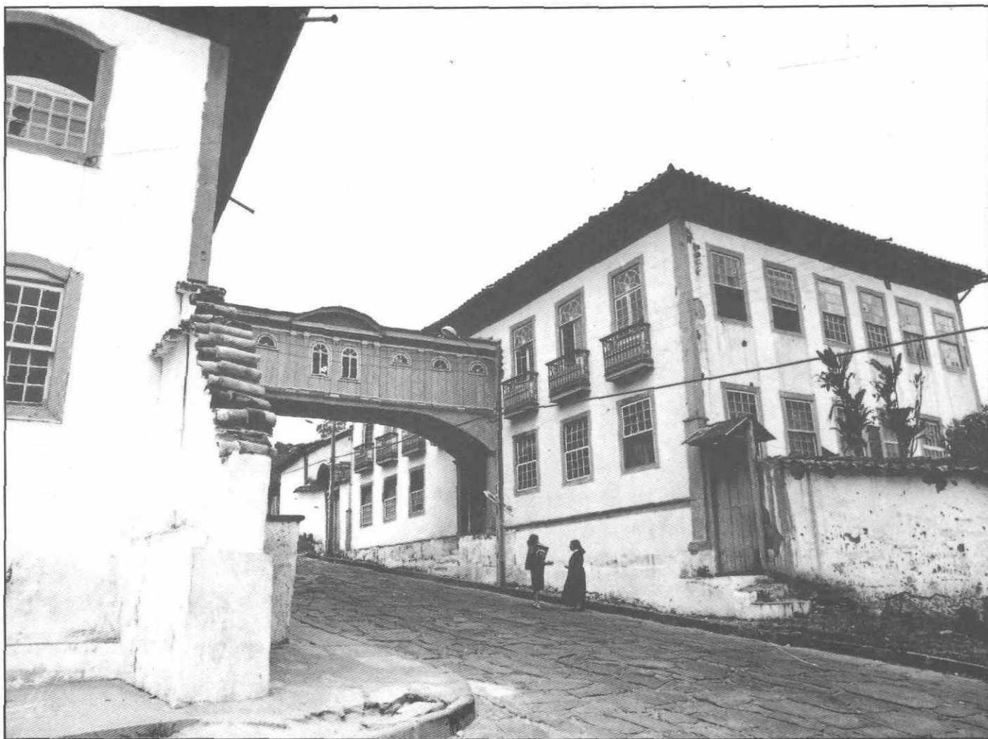
Diamantina - Passadiço da antiga Casa da Glória (atual Colégio Nossa Senhora das Dores).
