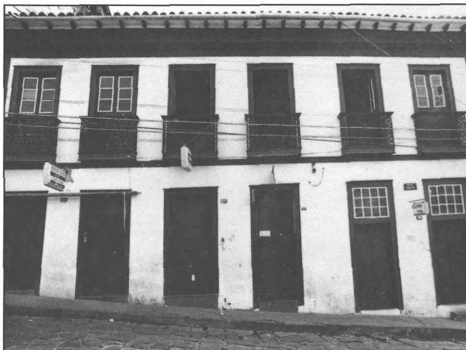
Diamantina. Sobrado da Rua Direita, esquina do Beco dos Brants.
