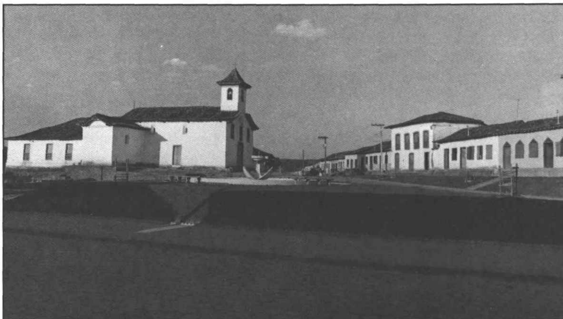
Chapada do Norte - Vista parcial, aparecendo a Matriz de Santa Cruz.
