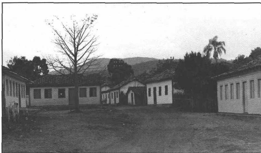
Distrito de Inbaí - Vista parcial.
