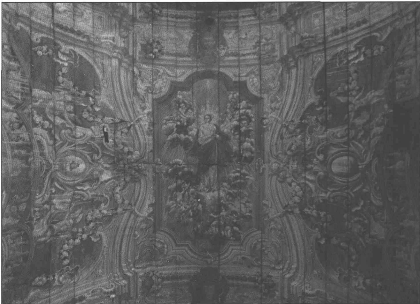
Couto de Magalhães de Minas - Matriz de Nossa Senhora da Conceição - Forro pintado da capela-mor.
